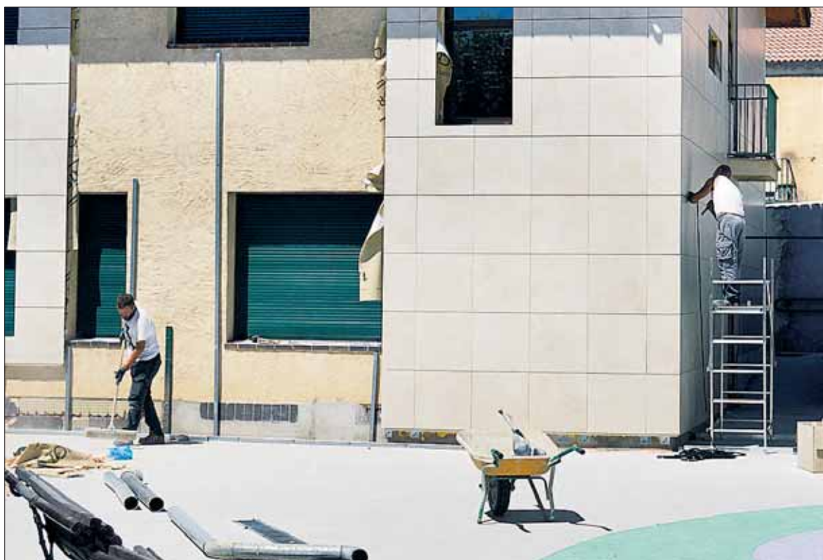
Renovación de fachada con mejora de eficiencia energética en el centro Nuestra Señora de la Esperanza. / CRISTINA YUSTA
