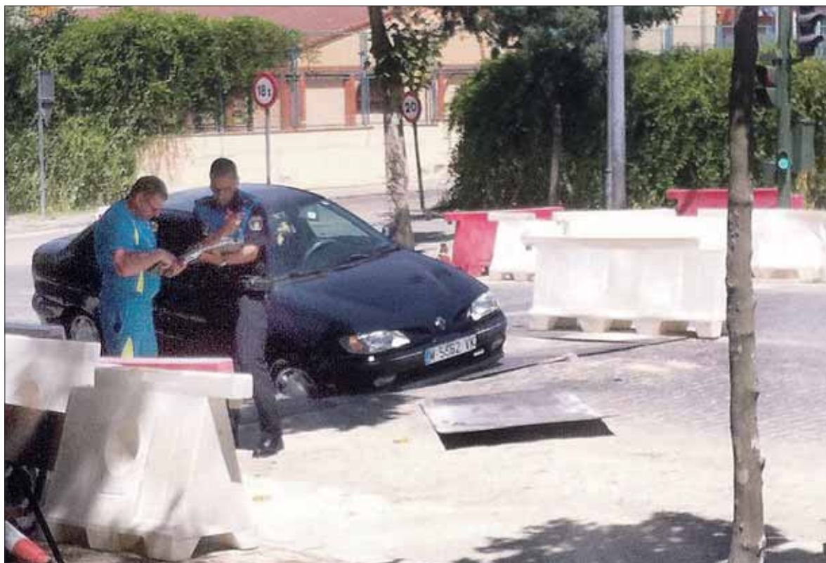
El turismo atrapado en un socavón provocado por las obras en la avenida de la Constitución. / EL ADELANTADO
