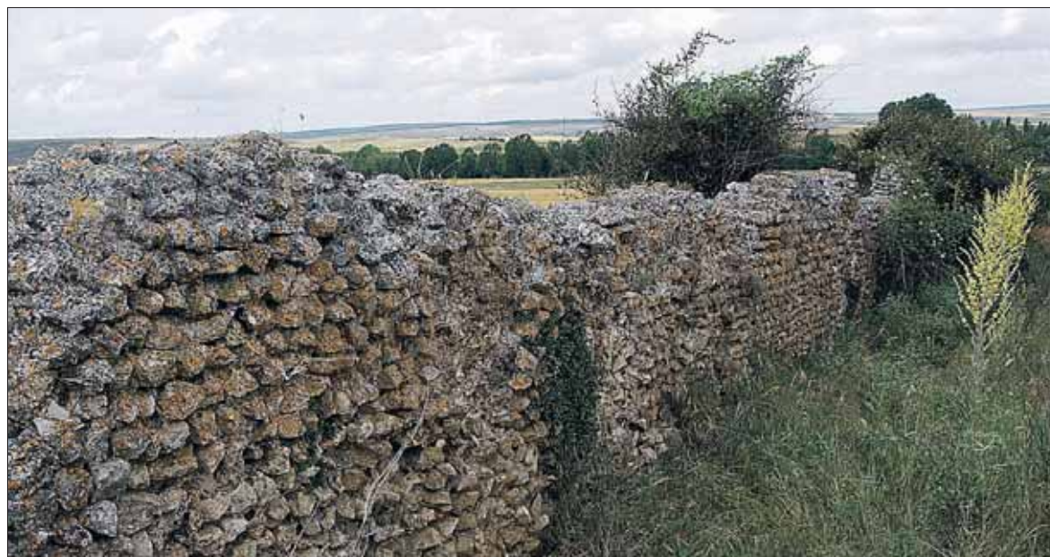
Excavación del ángulo nororiental del muro de cierre del foro pecuario (sup.) y vista parcial de 'Las Paredes'. / EL ADELANTADO
