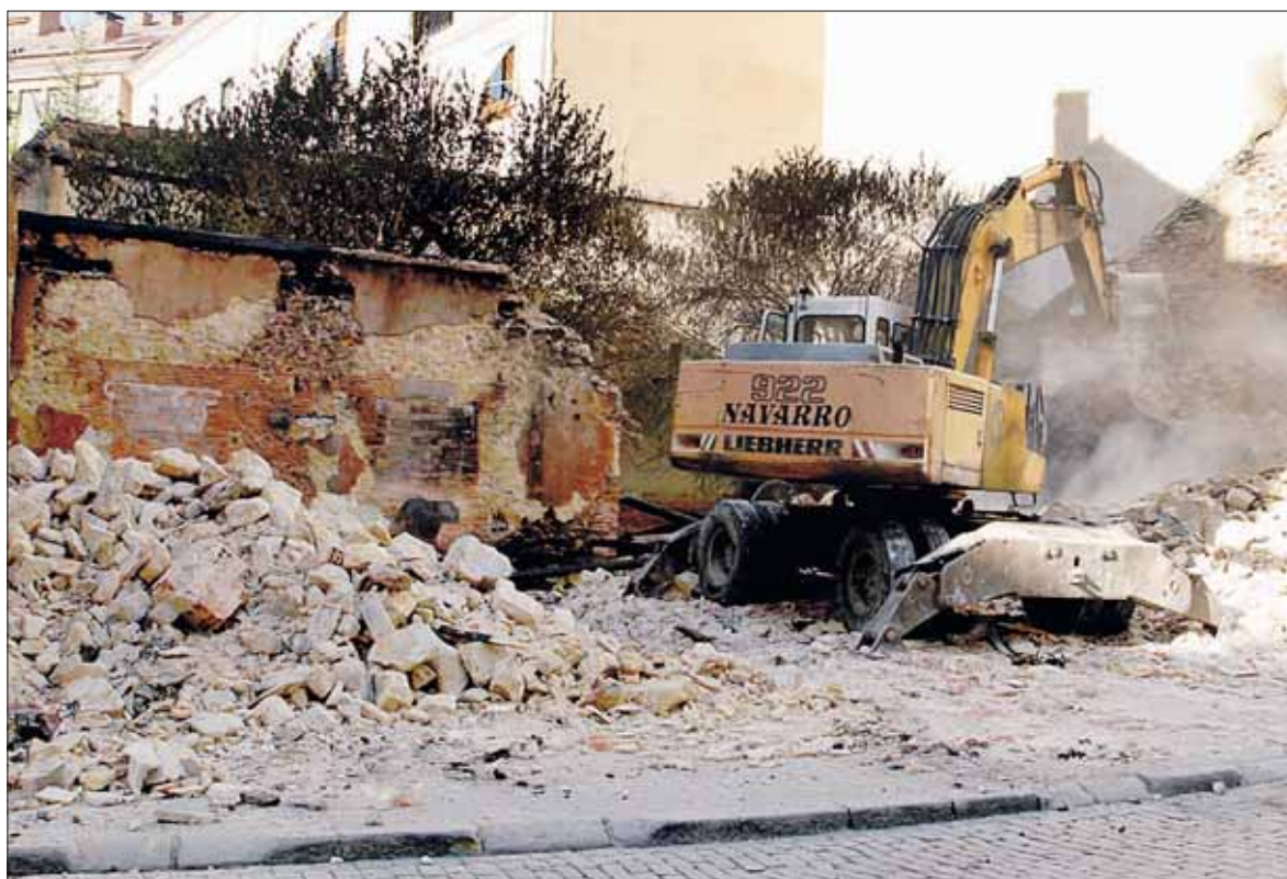
Los trabajos de derribo de la casa incendiada el lunes se llevaron a cabo en la jornada de ayer. / NEREA LLORENTE
