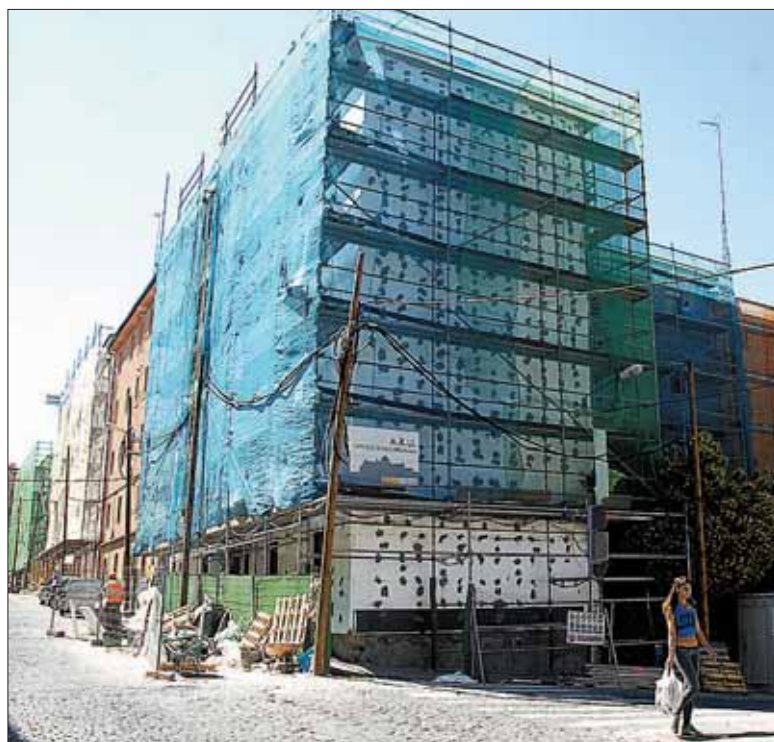
El ARU de San José permitirá la rehabilitación de 101 viviendas. / JUAN MARTÍN
