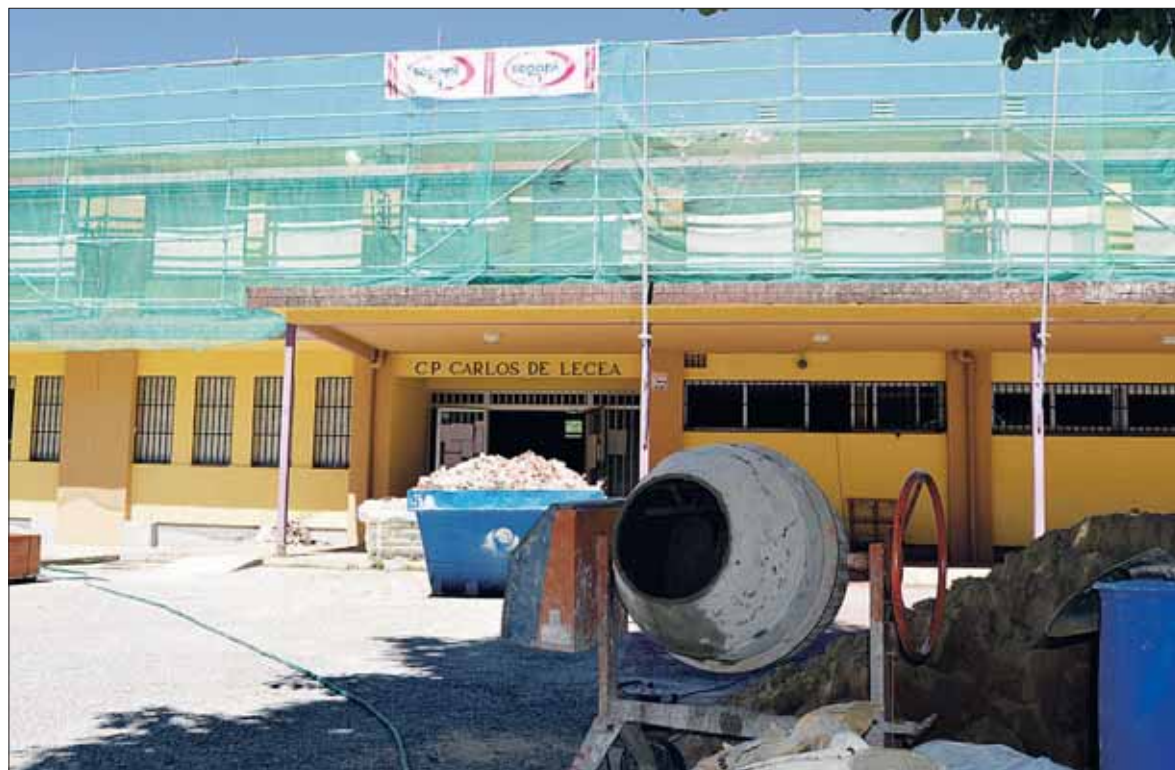
Los andamios tapan la fachada del colegio Carlos de Lecea, donde se está procediendo a renovar la cubierta. / CRISTINA YUSTA
