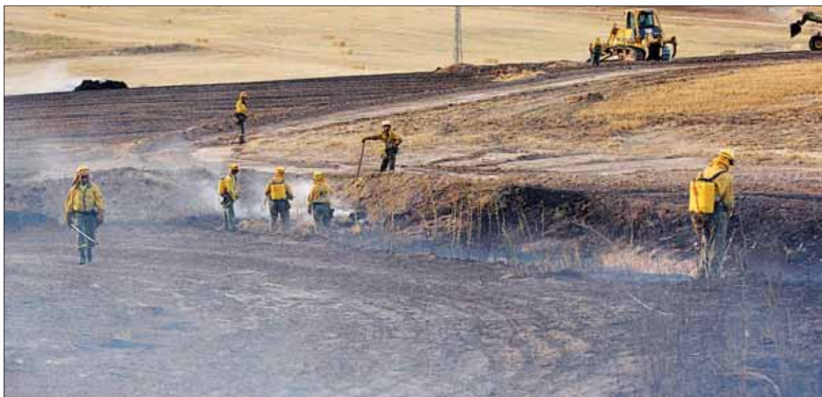
Diferentes operarios y maquinaria trabajan para la prevención de posibles incendios forestales. J.J.MARTÍN
