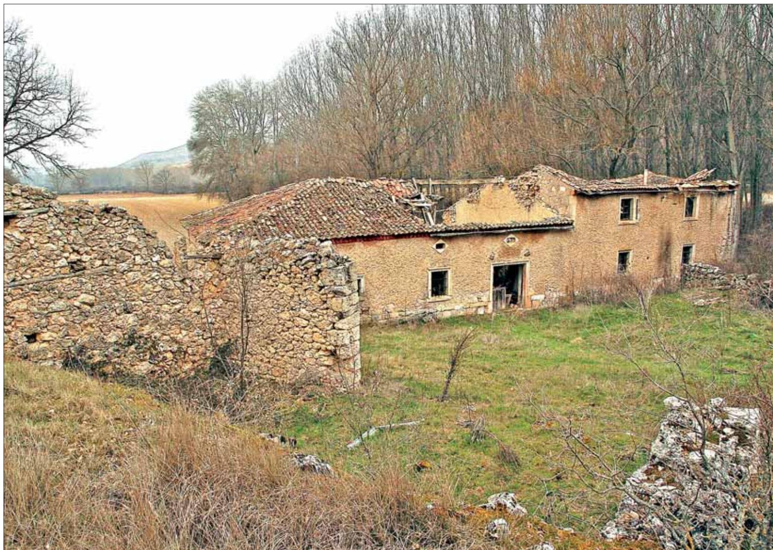
Los estragos del paso de tiempo, del abandono y del olvido: el Molino del Coto de San Bernardo en la actualidad.
