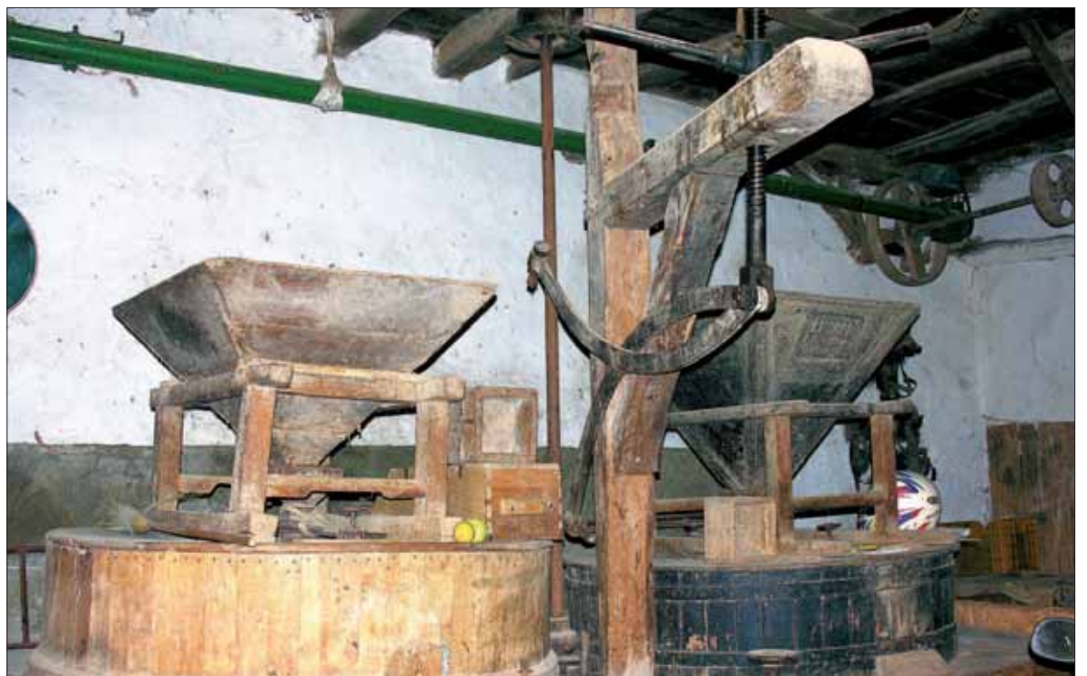
Sala de molienda del molino de Saldaña de Ayllón, con su dos empiedros al completo.
