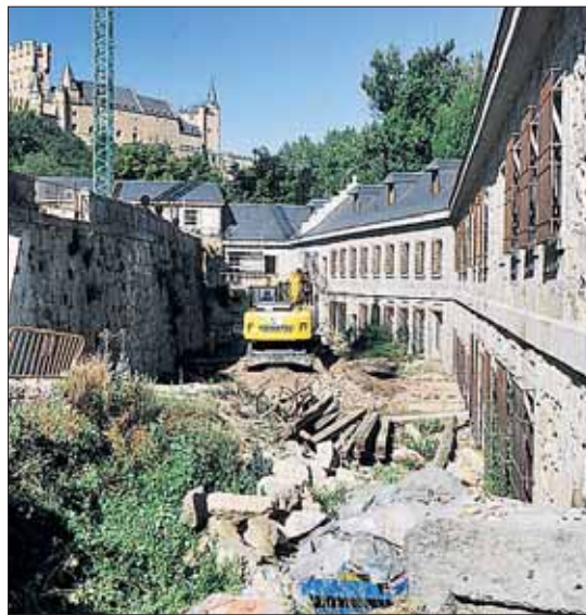
La Ceca durante las obras de reconstrucción. / KAMARERO
