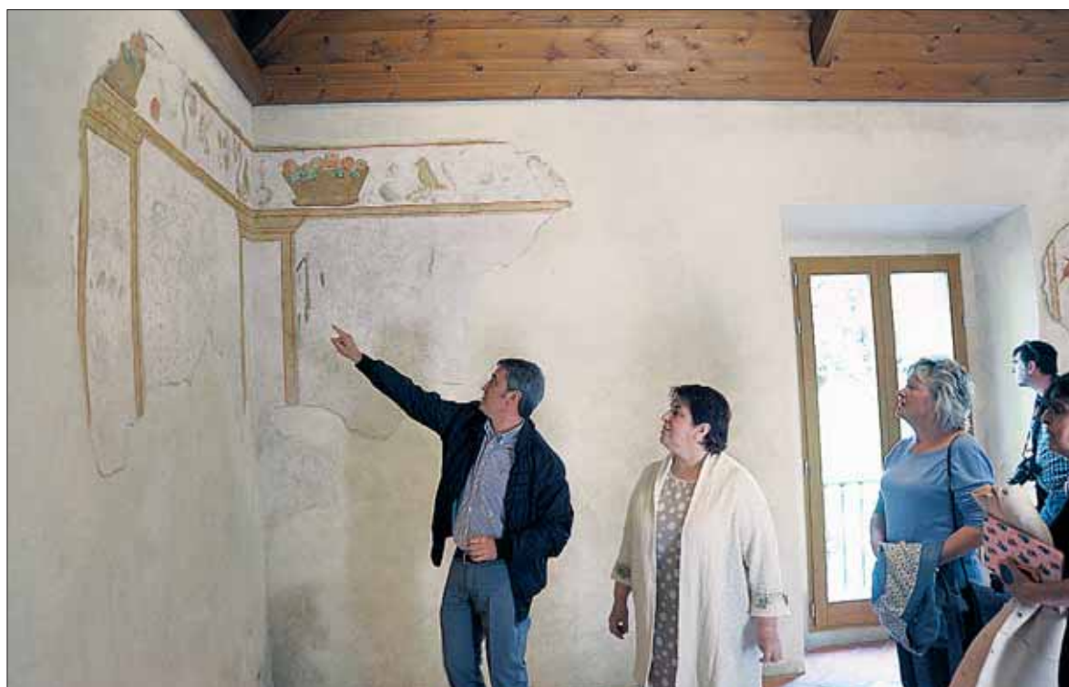
Técnicos y responsables municipales observan el trabajo llevado a cabo en el pabellón de pesca de Felipe II. / KAMARERO
