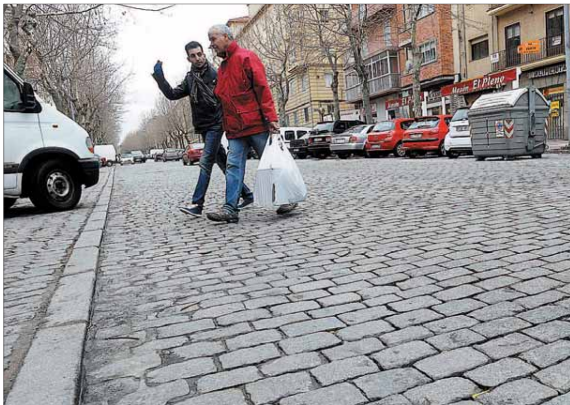
Los adoquines de la avenida de la Constitución pasarán a la historia con la pavimentación prevista en las obras. / KAMARERO
