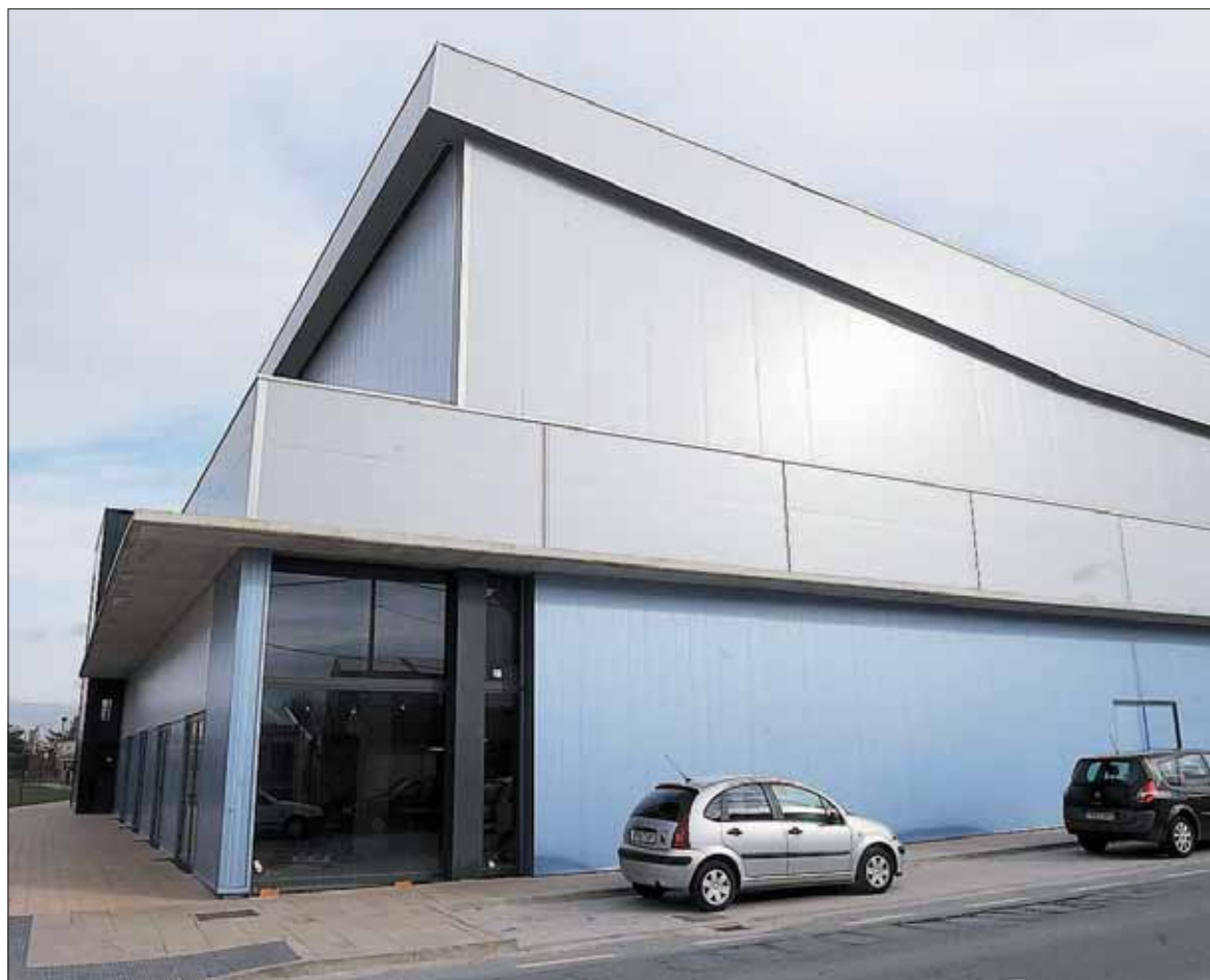
Vista del pabellón municipal de Nava de la Asunción, al que hay que dotar de todo el equipamiento. / KAMARERO
