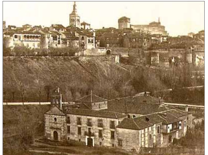
Estado primitivo en que encontraba el complejo antes de su restauración.
