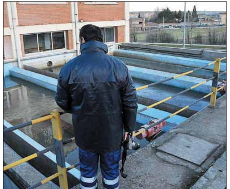
Un técnico comprueba la decantación en la ETAP de la carretera de La Granja. / J. M.
