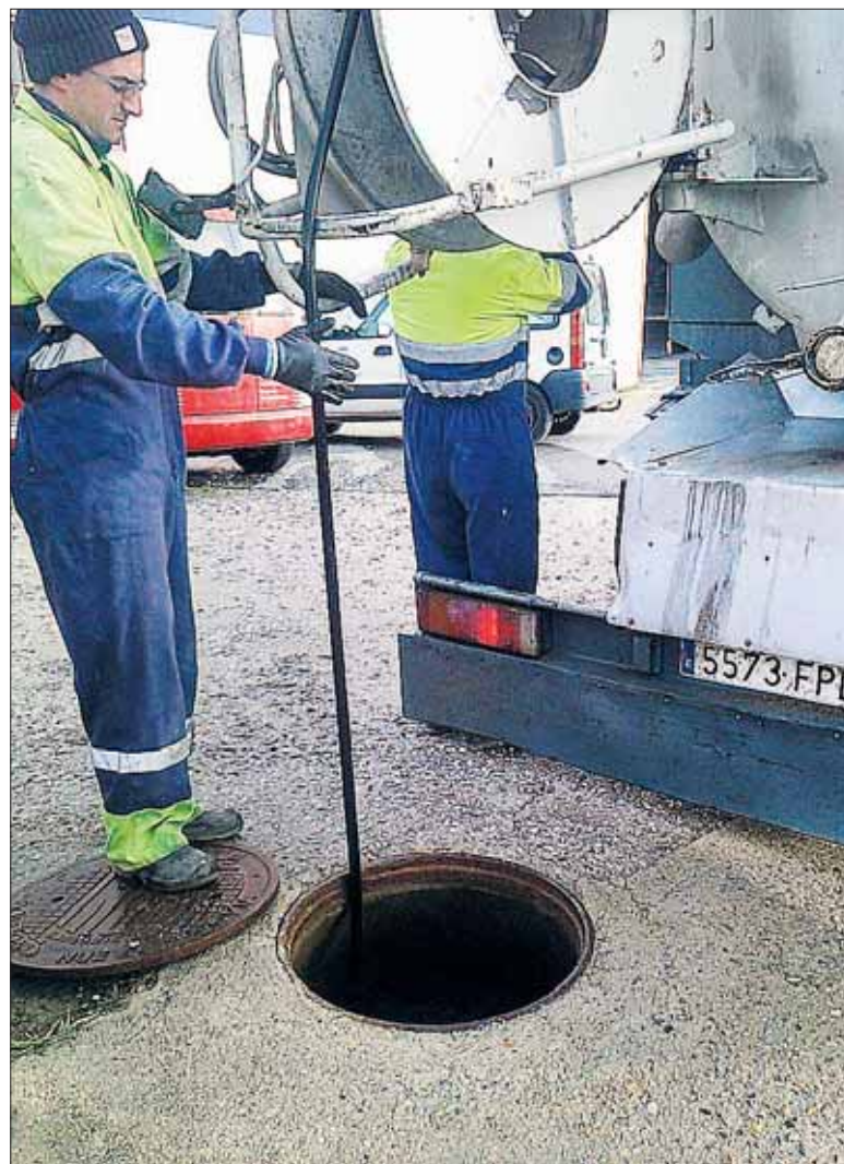
Los operarios desatascan una de las tuberías de la ciudad. / EL ADELANTADO
