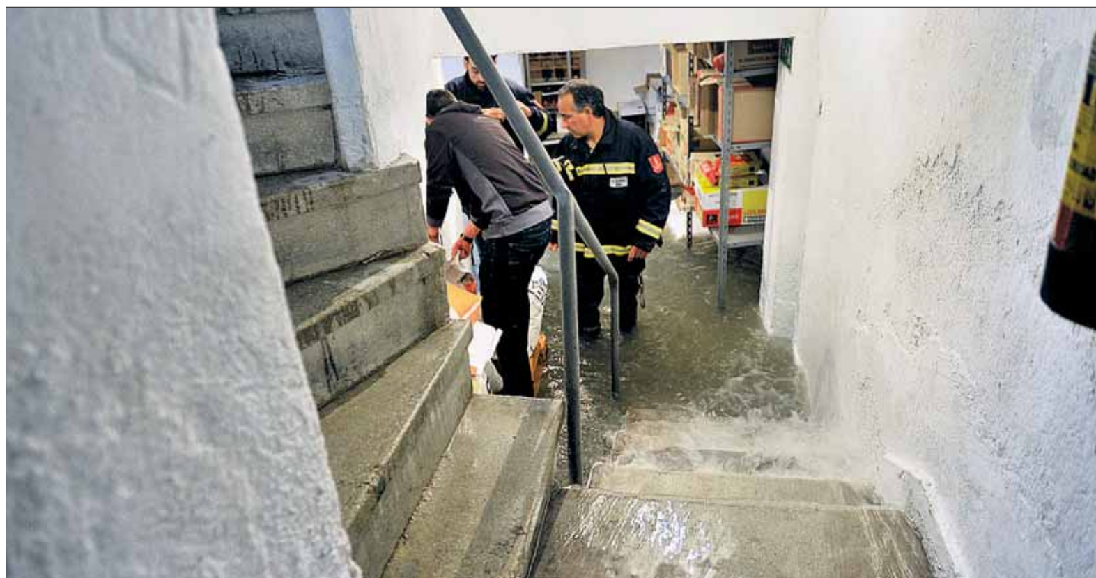
La principal causa de las indemnizaciones abonadas por la aseguradora del Ayuntamiento el año pasado fueron motivadas por daños por agua. / KAMARERO
