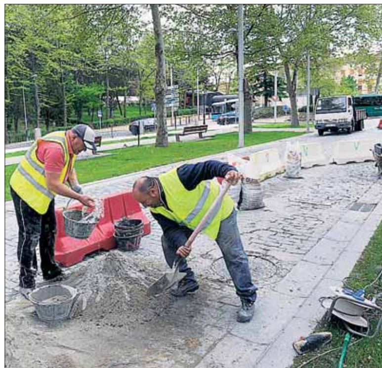
Obras parciales ejecutadas en mayo del año pasado en la avenida. / KAMARERO
