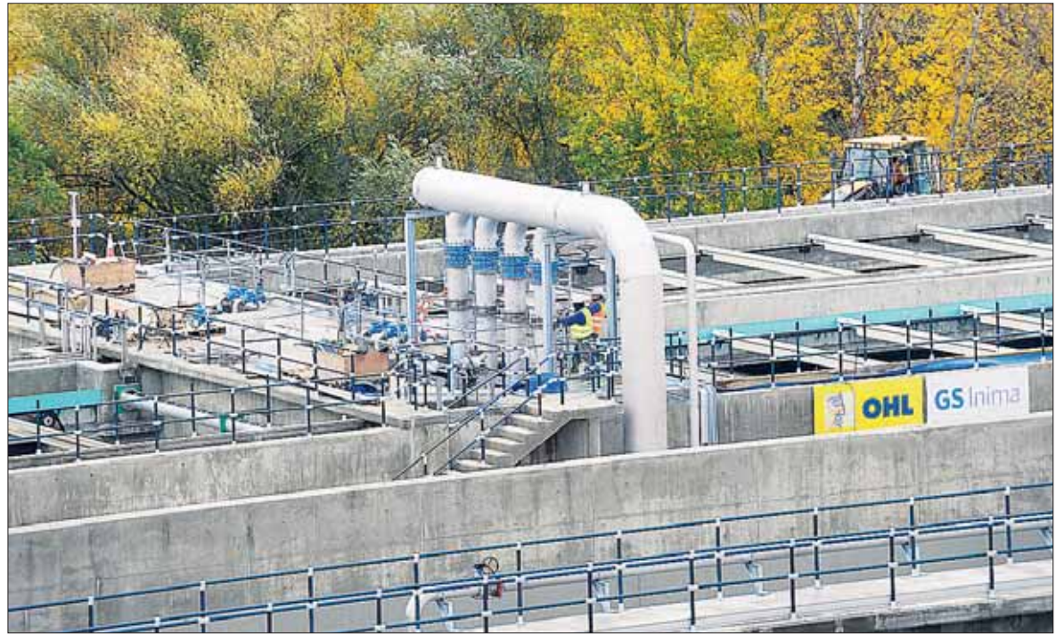
Las obras de la depuradora de Segovia serán recepcionadas en el primer trimestre del año. / KAMARERO
