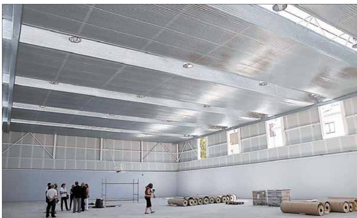
Interior del pabellón deportivo que comenzó a construirse en diciembre de 2010 en el patio del colegio 'El Peñascal' / JUAN MARTIN
