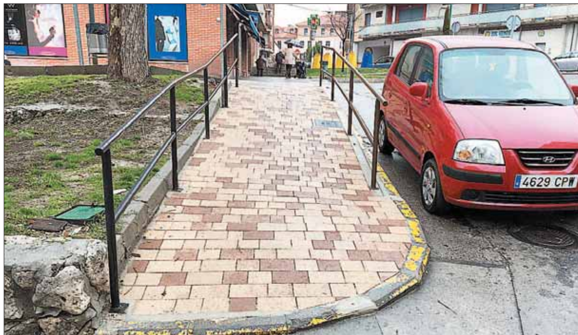
La acera del inicio de la calle Severo Ochoa ya está renovada para seguridad de los vecinos. / CHANTAL NÚÑEZ
