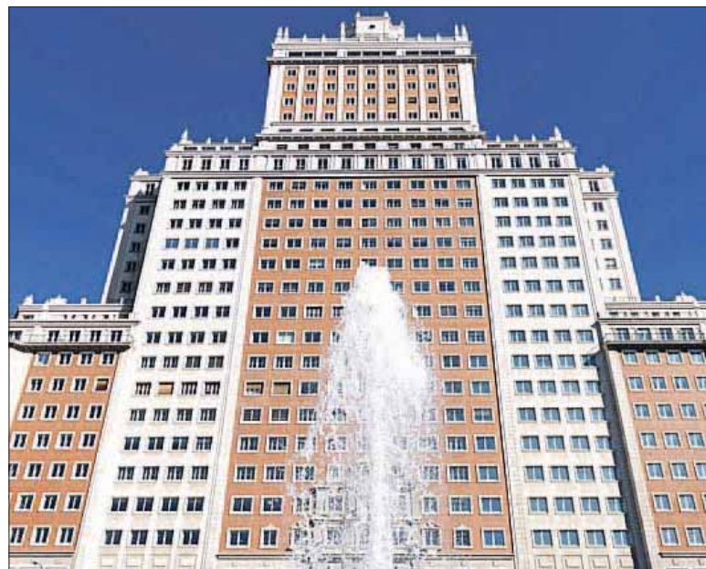
Una veintena de personas trabajaba en el proyecto de rehabilitación del edificio. / EFE
