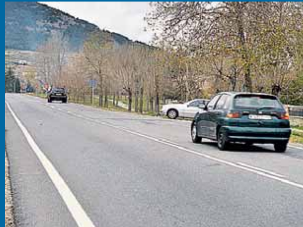
SG-500, a la altura del lugar donde hace un lustro se produjo un accidente mortal por la falta de iluminación.
