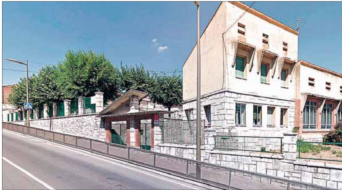
La empresa 'D-Todo Ingeniería y Desarrollo' se encargará de la obra del gimnasio. / C.N.
