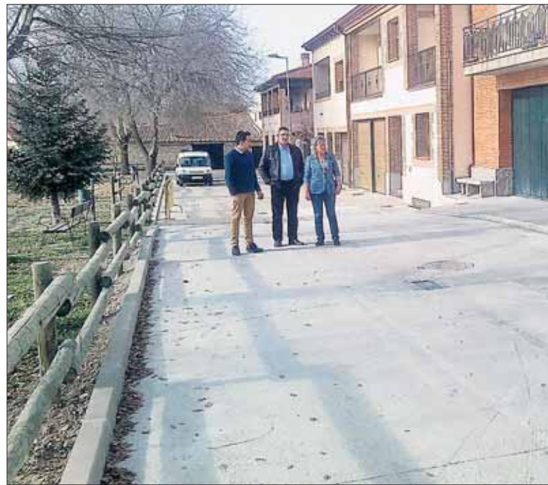
La concejala Paloma Maroto visitó los trabajos tras su finalización. / EL ADELANTADO
