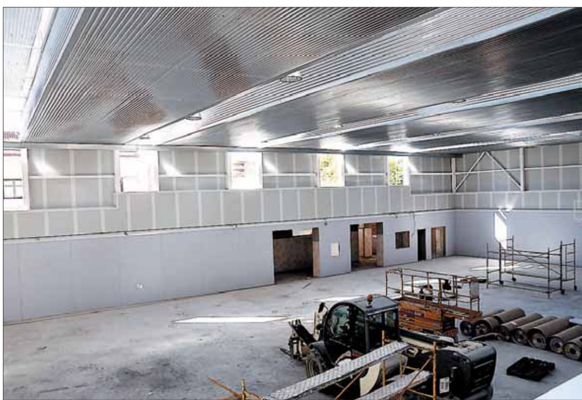
La obra se reactivará después de haber pasado más de año de su última paralización y cinco de su inicio. / JUAN MARTIN
