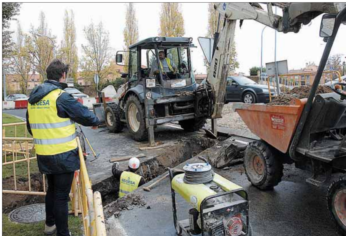
La concejala Paloma Maroto califica de muy necesaria la renovación de tuberías en la avenida Juan Carlos I. / JUAN MARTÍN
