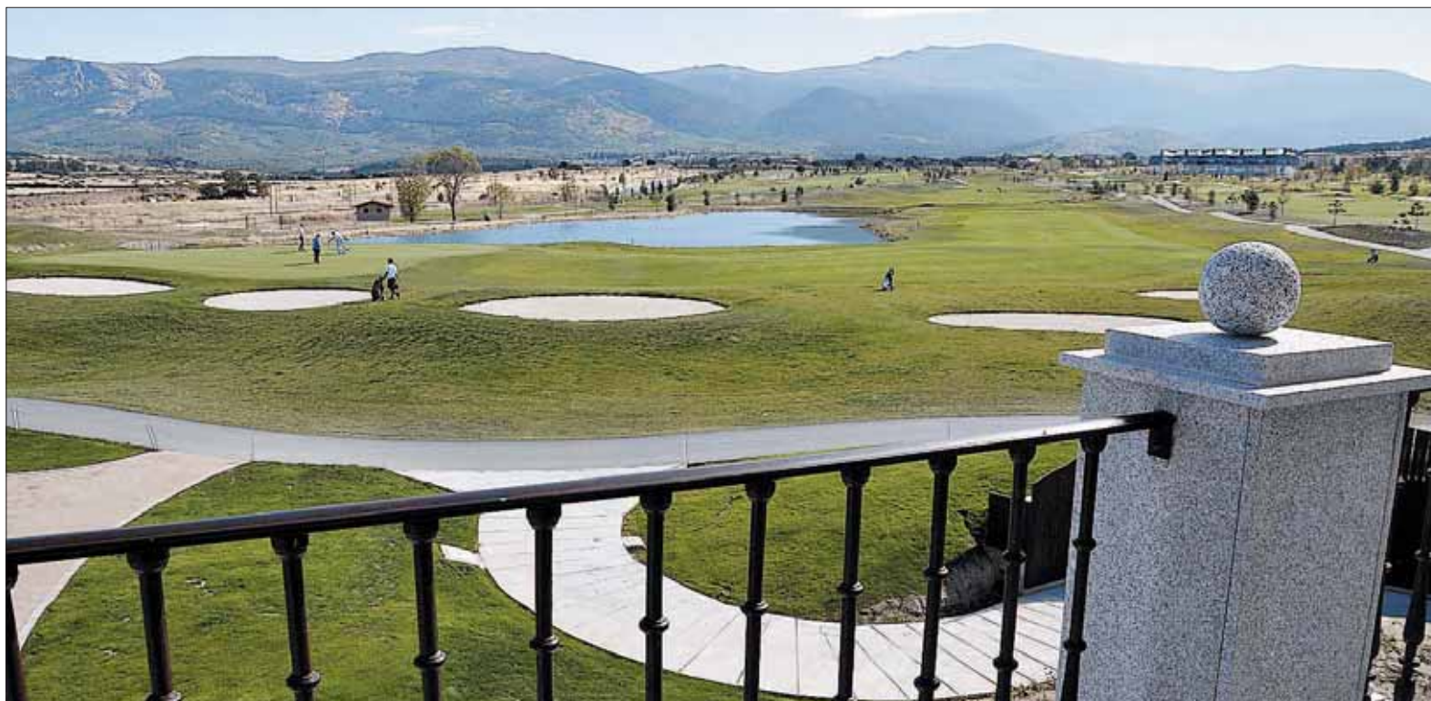
Imagen panorámica del complejo Segovia 21, que incluye un campo de golf y varias promociones de viviendas, situadas al fondo. / JUAN MARTÍN
