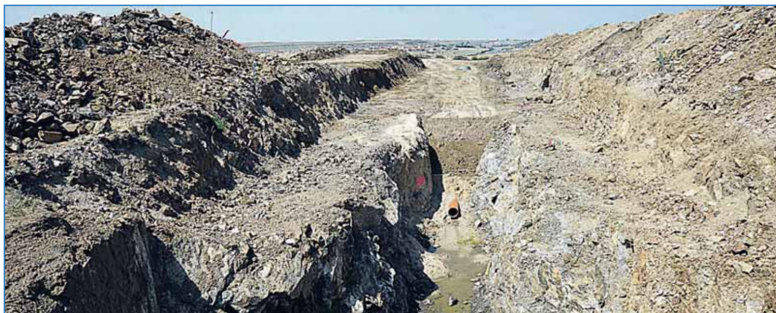
Colector de San Cristóbal de Segovia, una de las obras más demandadas y potentes.
