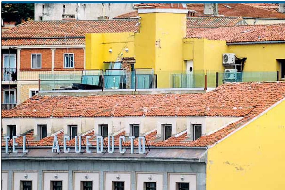
El Hotel Acueducto retira la estructura de su terraza. La empresa propietaria de este céntrico establecimiento hotelero ha procedido a retirar la estructura metálica de la cubierta, cumpliendo así la orden cursada por el Ayuntamiento de Segovia, que el pasado marzo paralizó las obras que se ejecutaban en la terraza y abrió un expediente sancionador por carecer de licencia. / FOTO: KAMARERO
