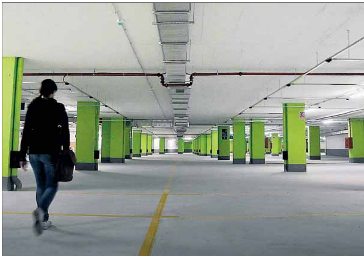
Interior del aparcamiento subterráneo construido en la huerta del antiguo convento de Las Oblatas de Segovia. // JUAN MARTÍN
