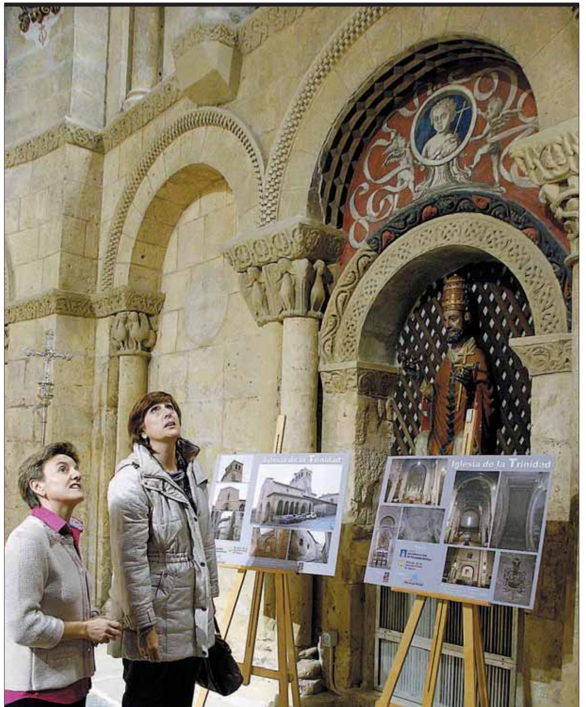
Dos feligresas de la parroquia observan la calidad de los trabajos realizados en el templo. / JUAN MARTÍN
