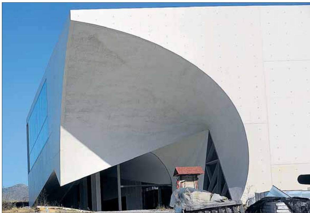
Estado actual del edificio CIDE del Círculo de las Artes y la Tecnología de Segovia. / KAMARERO
