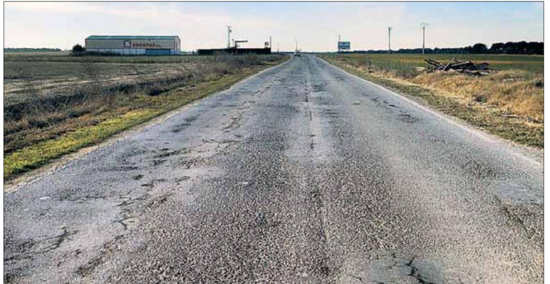
Los 23,5 kilómetros de firme de la carretera se encuentran en muy mal estado debido al constante paso de vehículos. / E.A.
