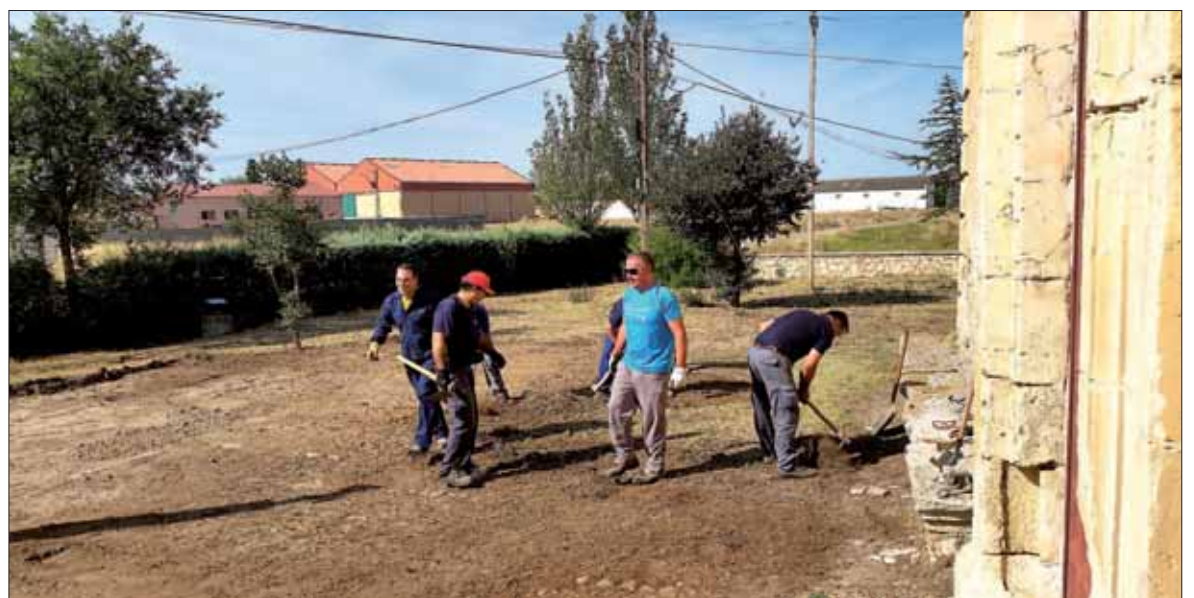
El grupo participó en una amena jornada de cooperación en la limpieza del empedrado de la iglesia. / A. PINELA
