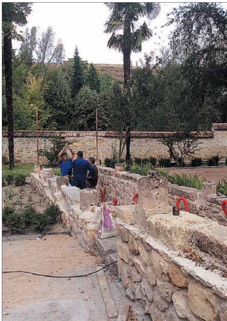
Las obras han permitido reconstruir varios muretes. / EL ADELANTADO
