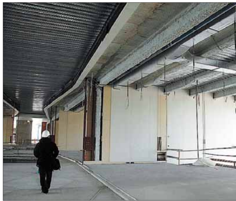
Una de las salas en construcción del edificio de emprendedores del CAT. / J.M.
