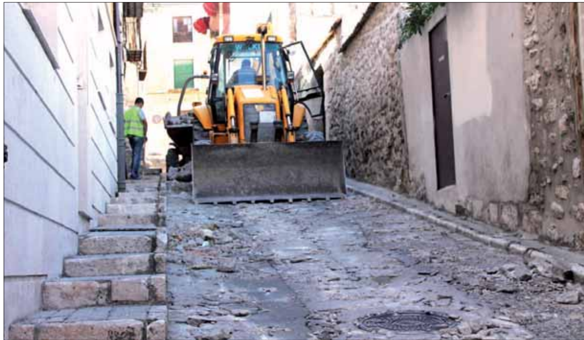
La intervención mantendrá los escalones de la calle pero se reconstruirán con adoquines. / C.N.
