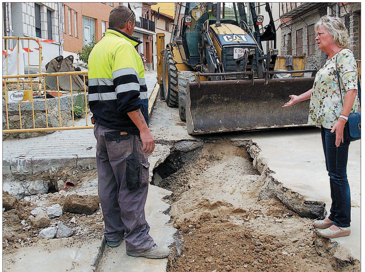
La concejala Paloma Maroto visitó esta semana las obras de renovación del colector. / EL ADELANTADO
