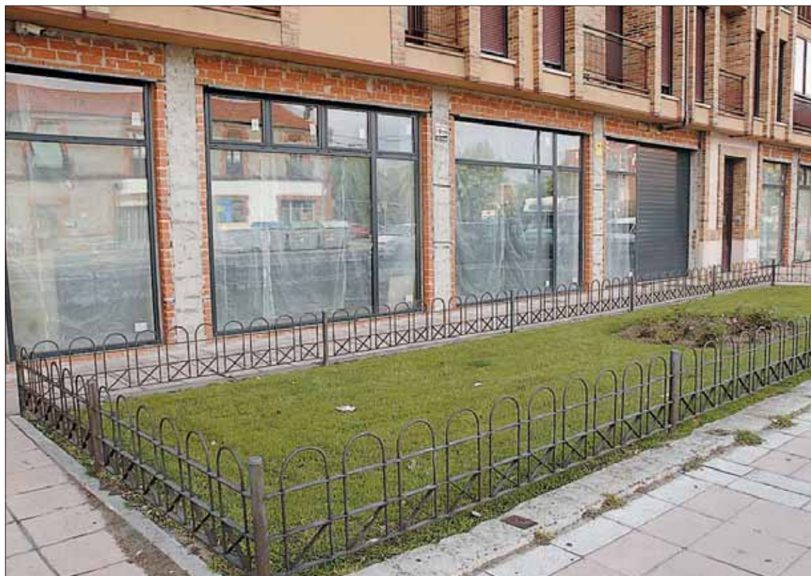
El local que albergará la nueva Oficina de Empleo de Segovia está ubicado en Vía Roma. / JUAN MARTÍN
