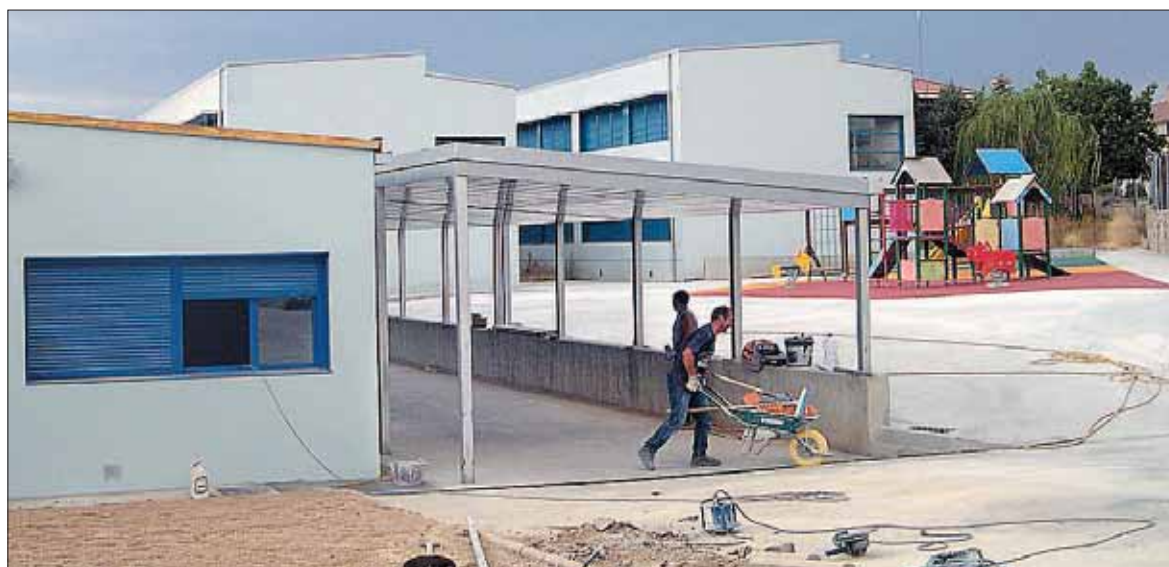
Los obreros recogen material junto al nuevo aula y zona de recreo para alumnos de Infantil del colegio de Palazuelos. /P. B.
