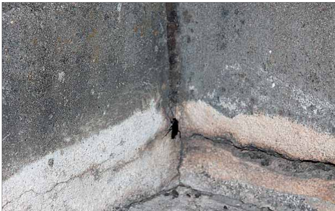
Las cucarachas surgen de las oquedades de muros sobre todo por la noche. / M.G.
