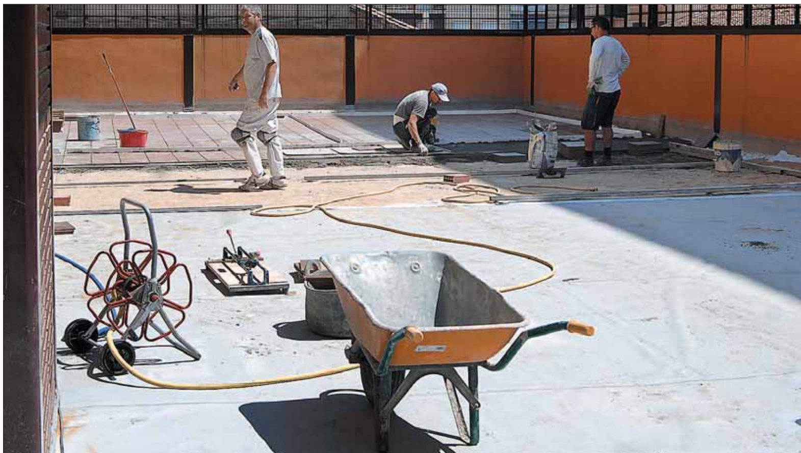
Los trabajadores de Construcciones y Reformas César Piquero González cubrían ayer con baldosas la nueva lámina de impermeabilización de la terraza. / ELENA PEÑA
