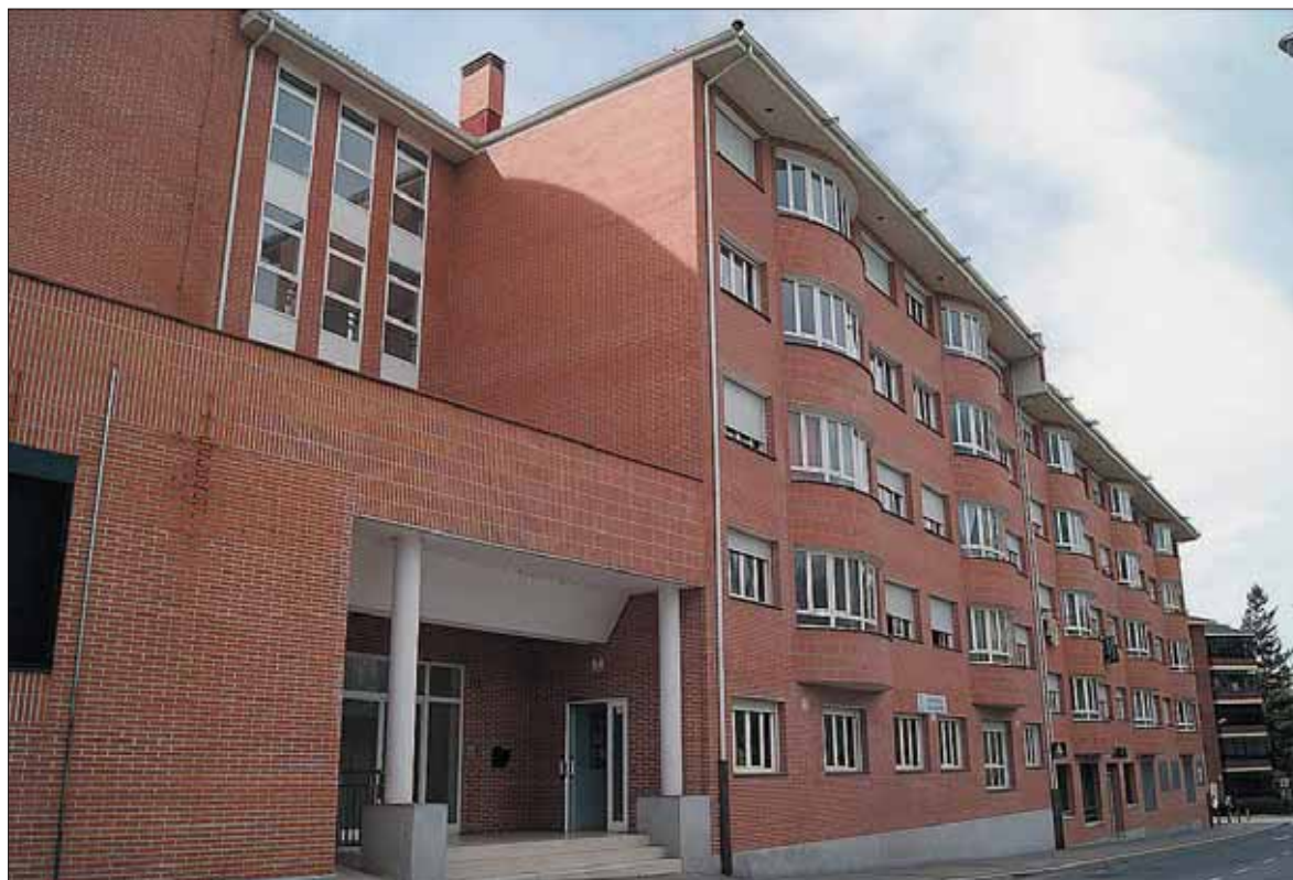
Edificio en el que se encuentran las viviendas municipales, en la calle Bomberos. / EL ADELANTADO
