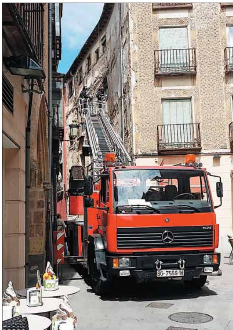
Los bomberos durante su intervención ayer en el edificio. / EL ADELANTADO
