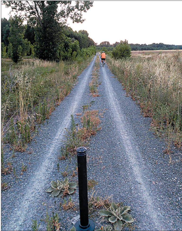
Estado actual de la vía, en algún tramo, denunciado por los usuarios. / E.A.
