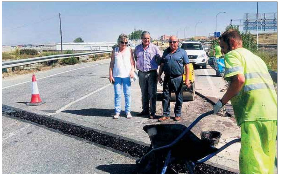
Los operarios se afanaban ayer en las obras de renovación de las juntas de dilatación del puente. / EL ADELANTADO
