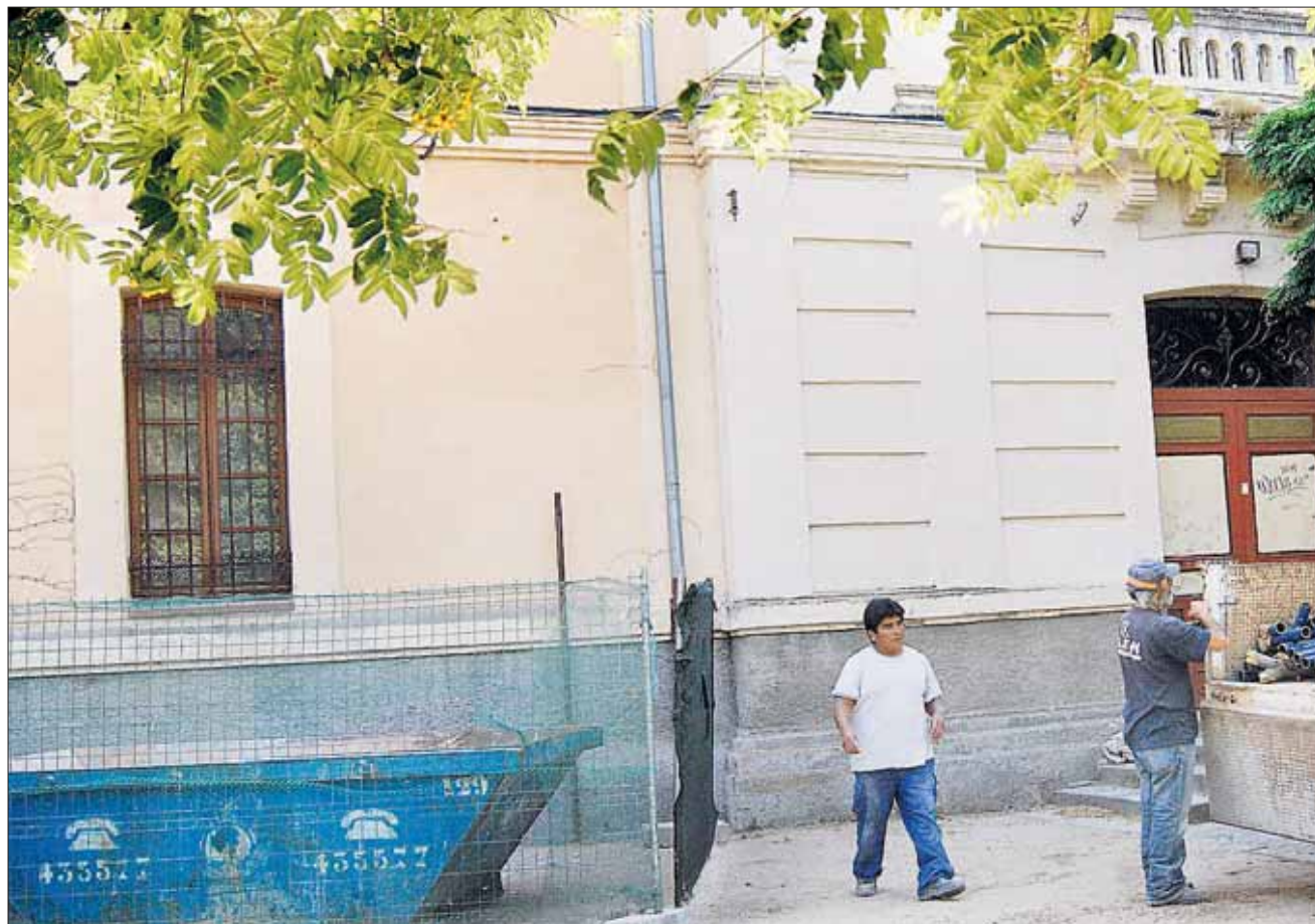
Los trabajos de mejora energética de las instalaciones del histórico instituto 'Mariano Quintanilla' están en ejecución en el mes de julio, con
