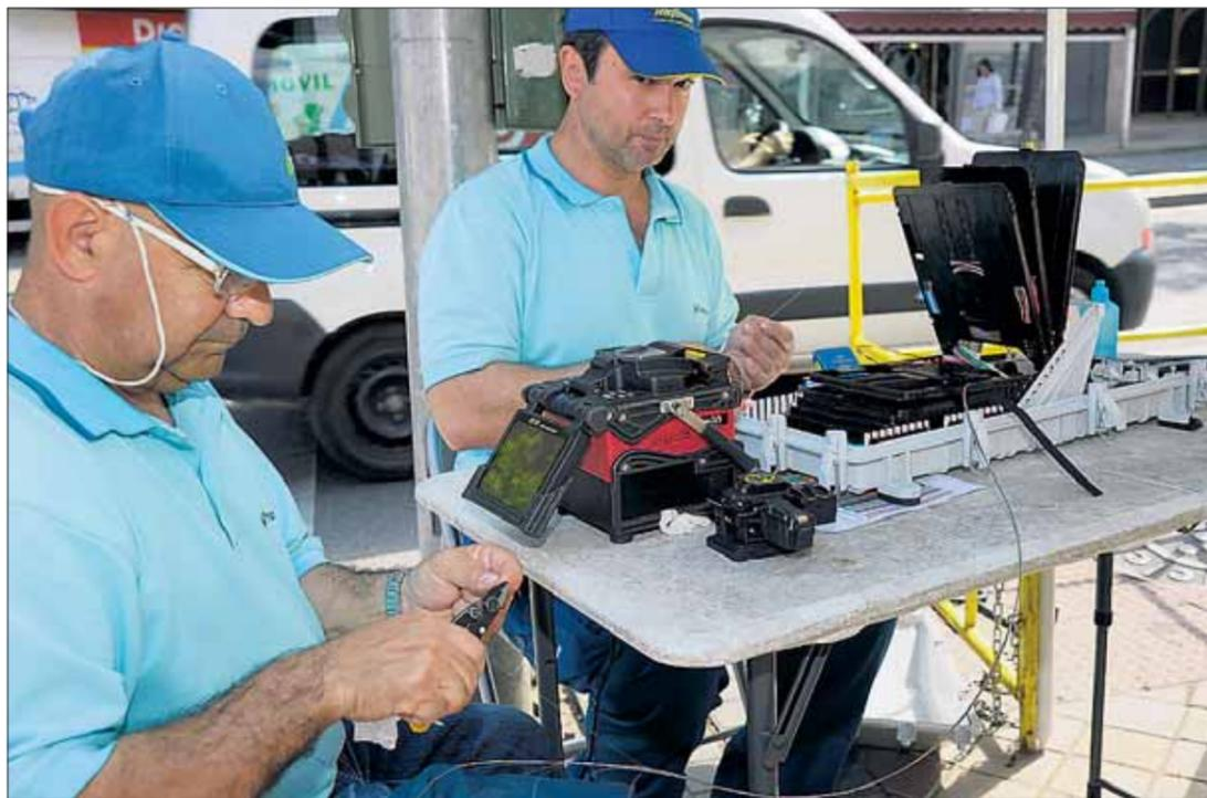
Dos empleados de Telefónica, durante la fusión de cables de fibra óptica en la Avenida Ezequiel González. / EL ADELANTADO
