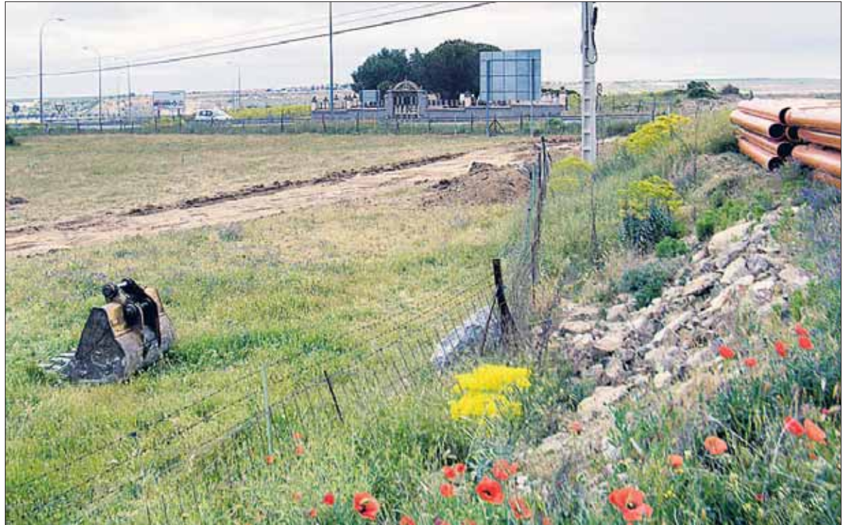
Estado actual de las obras del futuro colector de San Cristóbal de Segovia. / EL ADELANTADO
