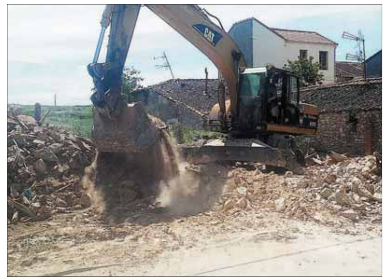
Una retroexcavadora derribó ayer el inmueble, en estado de ruina. / EL ADELANTADO
