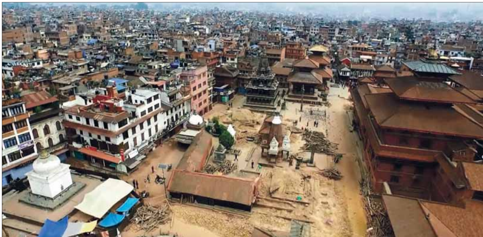
Vista aérea de la plaza nepalí de Patan Durbar en Lalitpur, con numerosas construcciones derrumbadas tras el seísmo de 7,9 grados ocurrido el sábado. / EFE
