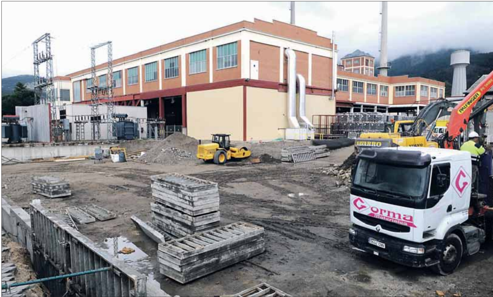
Actuales obras del derribo de las naves que se utilizaban como almacén de refractarios para el horno. / JAVIER SEGOVIA
