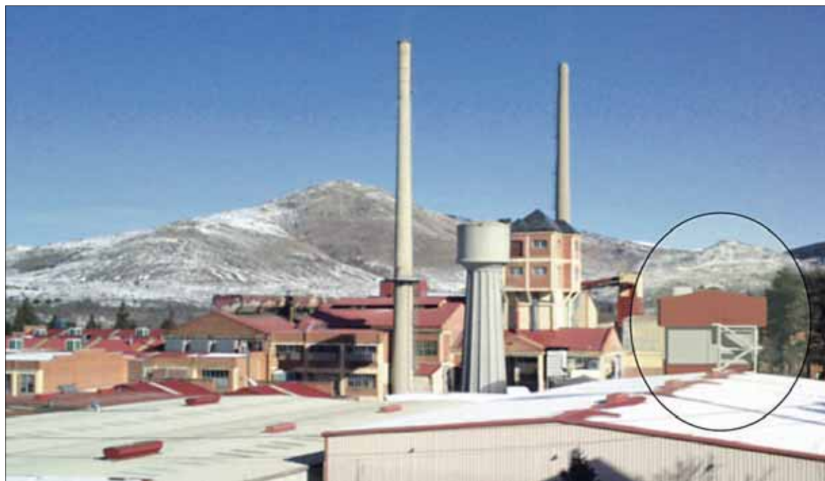
Composición de los filtros que se instalarán este verano en las dos chimeneas. / E.A.
