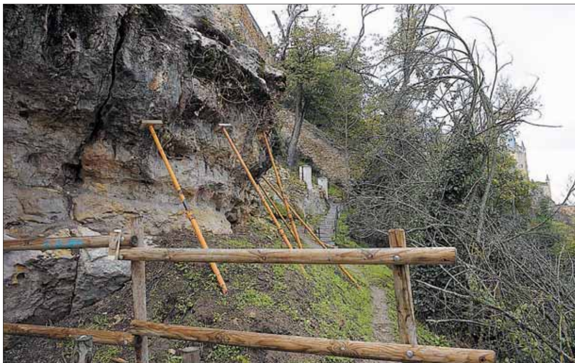
Las obras de consolidación se realizarán en una roca de la muralla próxima a la Cueva de la Zorra. / KAMARERO
