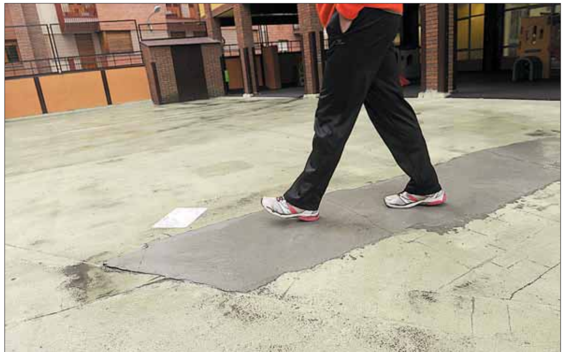
Patio interior del colegio público de Santa Eulalia, donde el Ayuntamiento ha realizado obras puntuales de 'parqueo'. // J.M.
