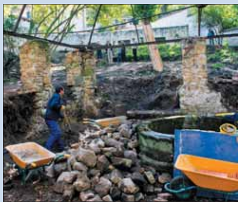
Obras de acondicionamiento en el jardín. /KAMARERO
