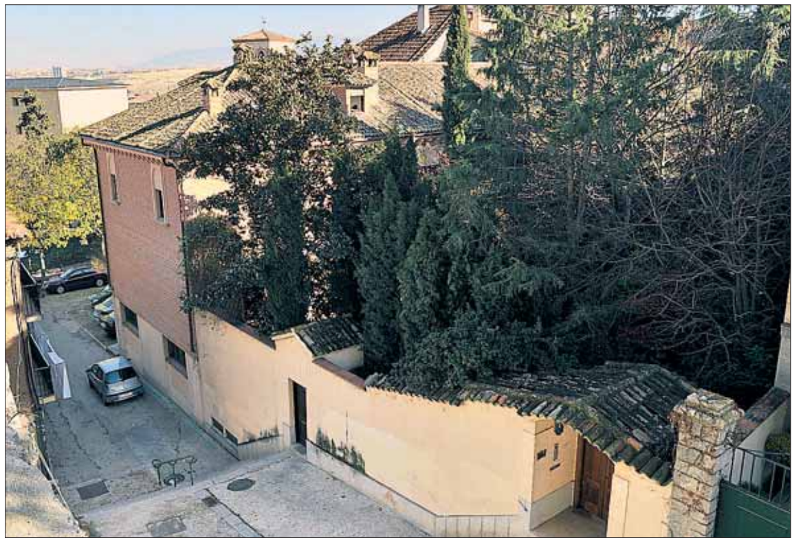
Los tribunales anulaban la licencia de la Casa de la Parra en 1996 y han ordenado su derribo. / KAMARERO
