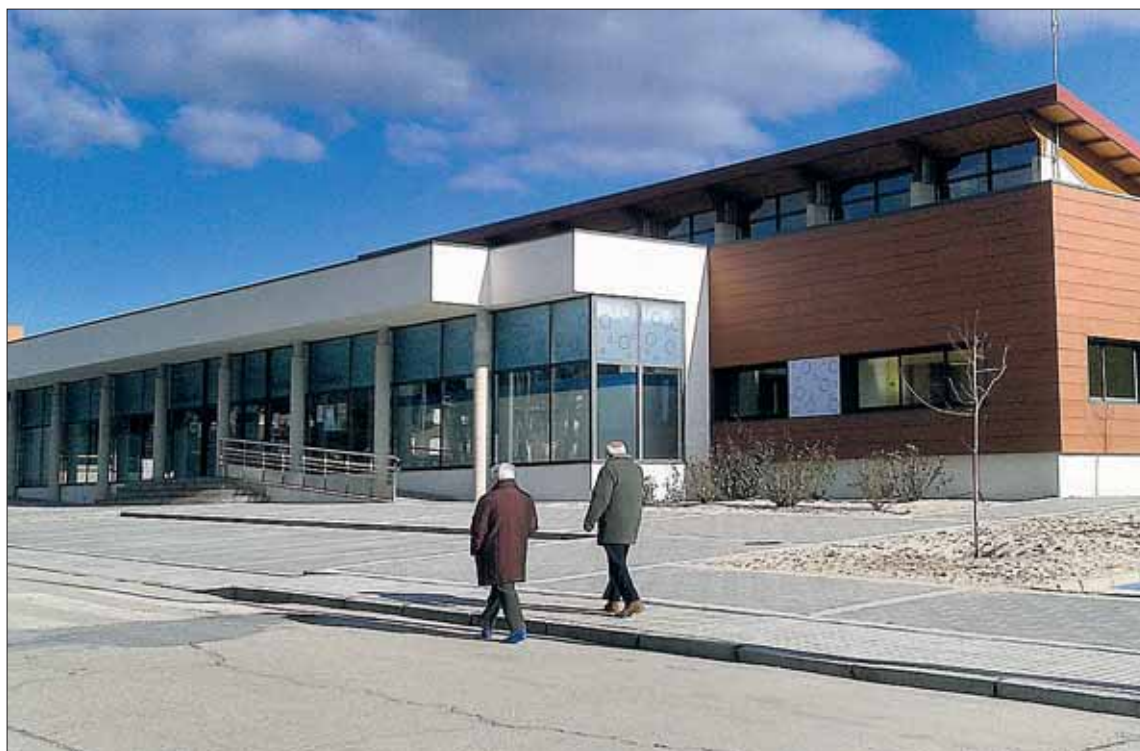
La piscina climatizada será una de las principales instalaciones municipales que usaría la nueva instalación. / F. DESCALZO
