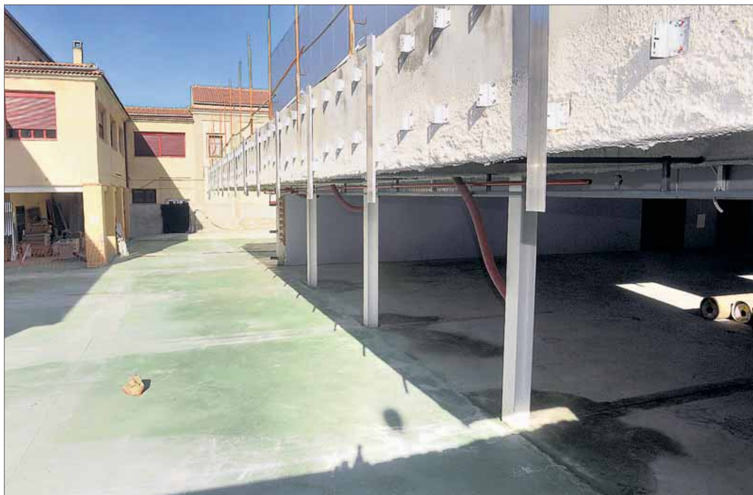
La empresa volvió a las obras del colegio El Peñasal en diciembre para crear una pista de hormigón verde y trabajar en el interior del pabellón. / KAMARERO
