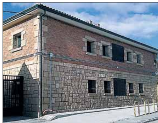
Casa-cuartel de la Guardia Civil. / FOTOS: F. D.
