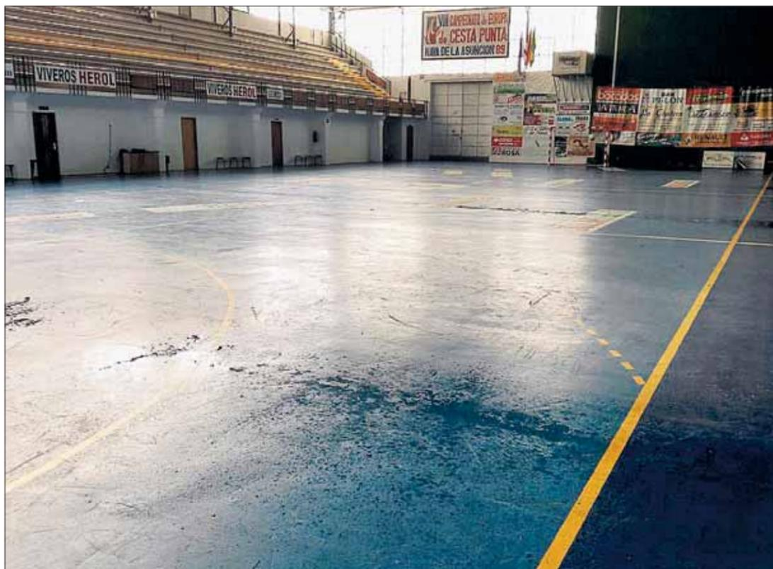
El frontón de Nava de la Asunción, con las goteras propias de la condensación que sufre. / EL ADELANTADO
