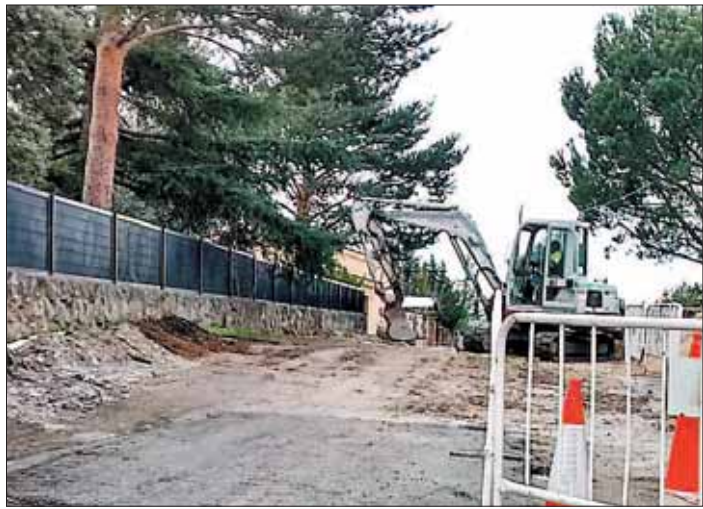
Los trabajos ya han comenzados desde hace unos días. / A.PINELA
