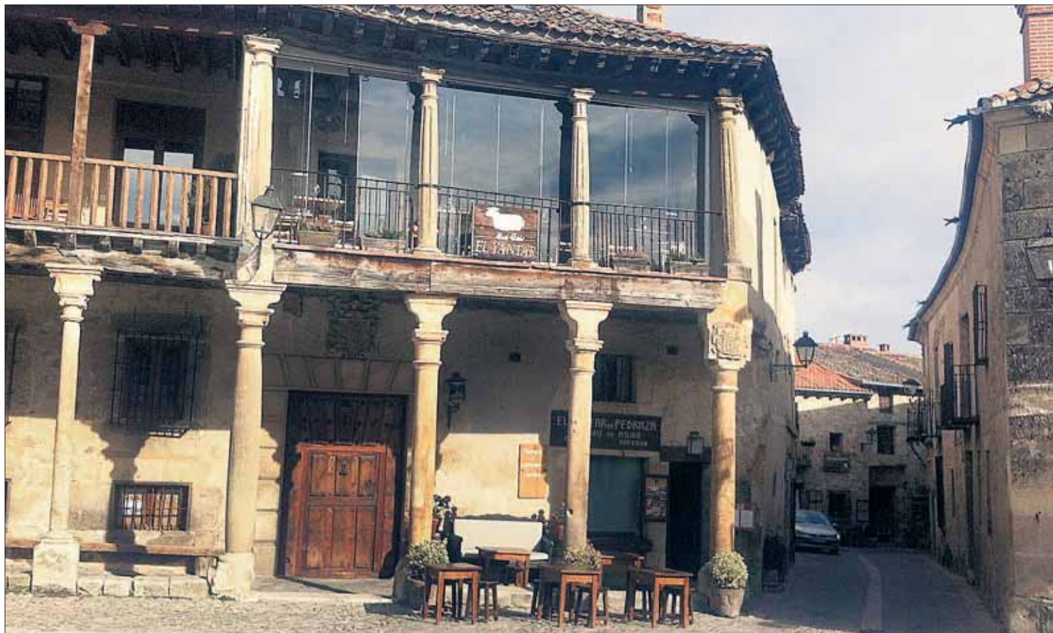
Fachada de la casa ubicada en la Plaza Mayor de Pedraza de la Sierra, cuya balconada ha sido cerrada con perfiles metálicos y vidrio recientemente. / EL ADELANTADO
