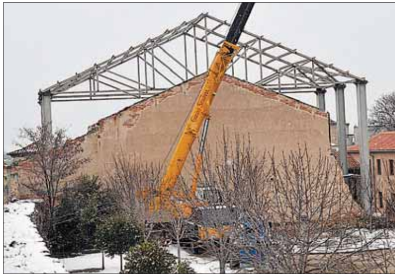
Una grúa servirá para el desmontaje de la cubierta metálica. / JUAN MARTÍN
