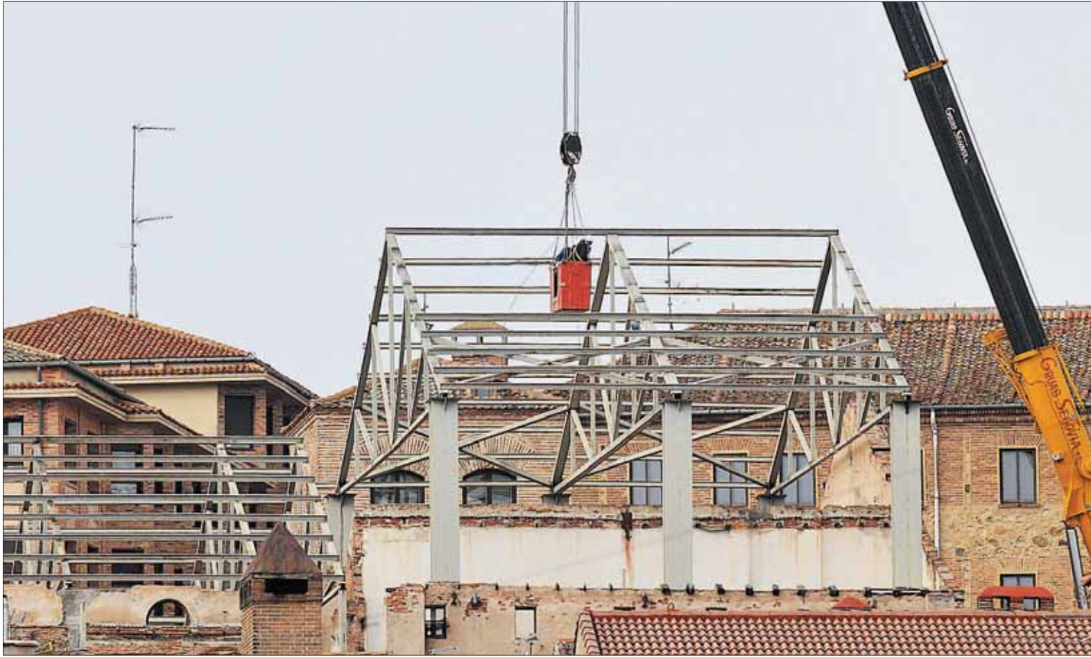
La empresa adjudicataria comenzó ayer con todos los preparativos para la retirada de la estructura a lo largo de las dos próximas semanas. / JUAN MARTÍN
