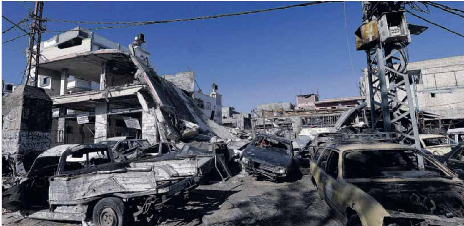
Viviendas palestinas de la Franja de Gaza que quedaron destruidas tras los ataques israelíes sobre los que se investigan posibles crímenes de guerra. / EFE
