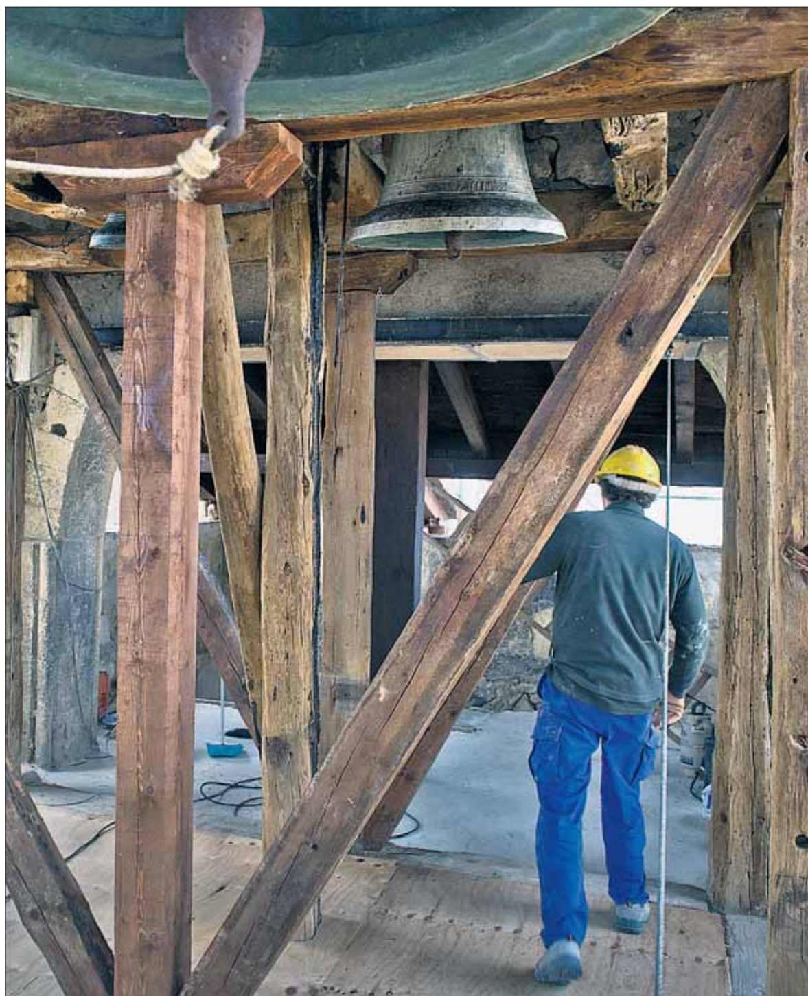
Un obrero revisa los trabajos realizados en la consolidación de la torre del templo. / KAMARERO
