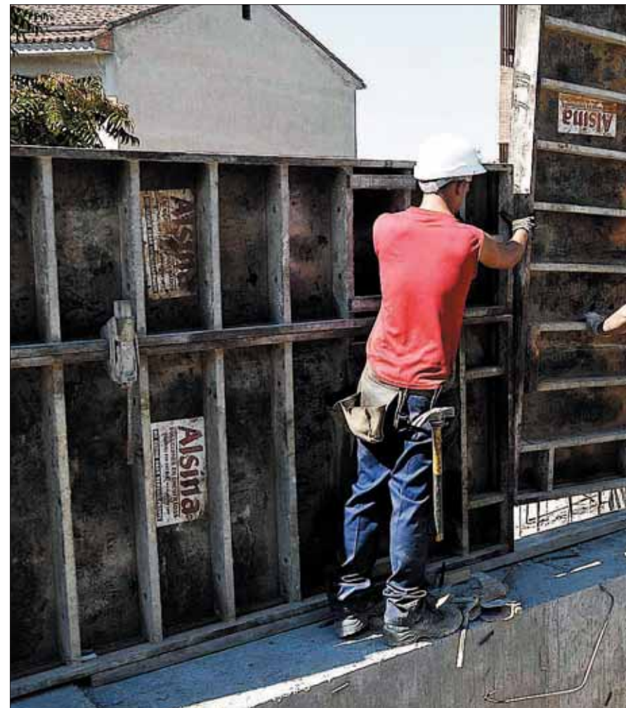
Trabajadores de la construcción en la obra de un edificio de la capital segoviana. Este sector ha
