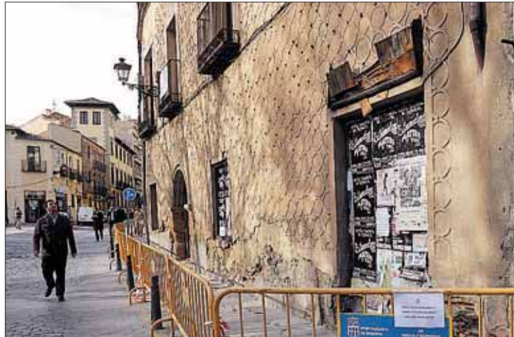
Las vallas impide a los peatones transitar junto al edificio. / KAMARERO
