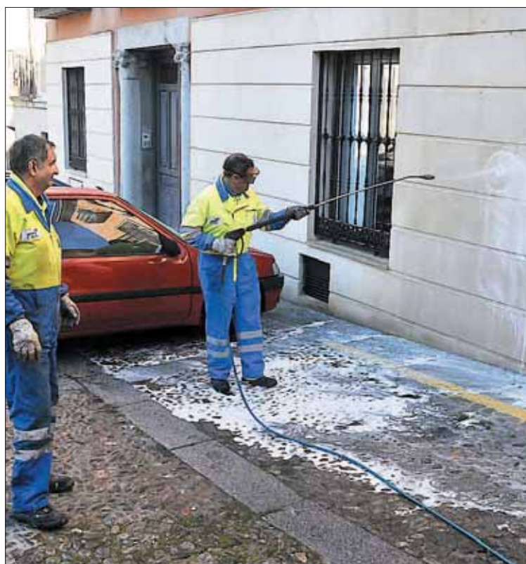
En la foto de arriba, una de las pintadas realizadas en la fachada de un edificio de la plaza de San Esteban. Abajo, los operarios en pleno proceso de limpieza. / J.M.
